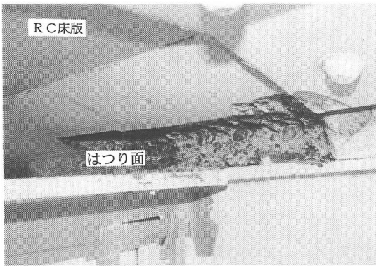
写真-3 ウォータージェットによるはつり面
