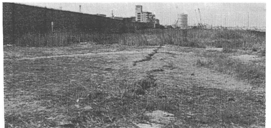
写真-3 高水敷の状況
