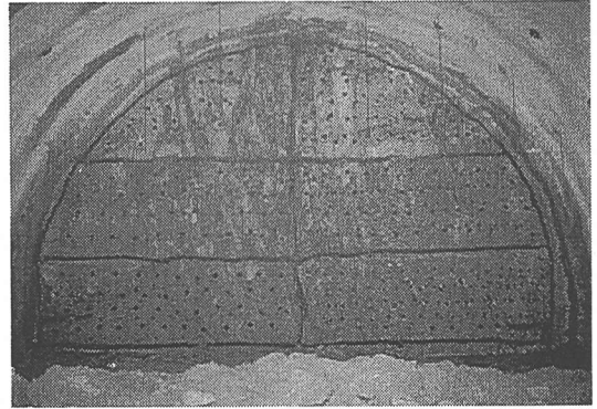
写真-2 穿孔終了状況
