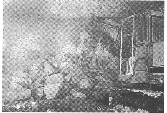
写真-5 二次破碎状況
