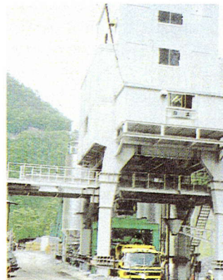
写真-2 プラント全景
