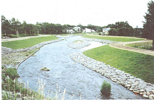
(a) 実際の護岸工の状況写真
