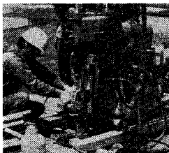
検出器埋設孔穿掘
