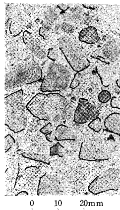
写真-1 クラック図の一例 (応力履歴は σ<sub>oc</sub>/σ<sub>0</sub>=1.25, τ<sub>oc</sub>/σ<sub>0</sub>=0)
