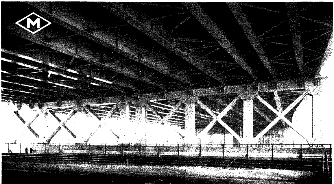
第三京浜川崎高架橋
