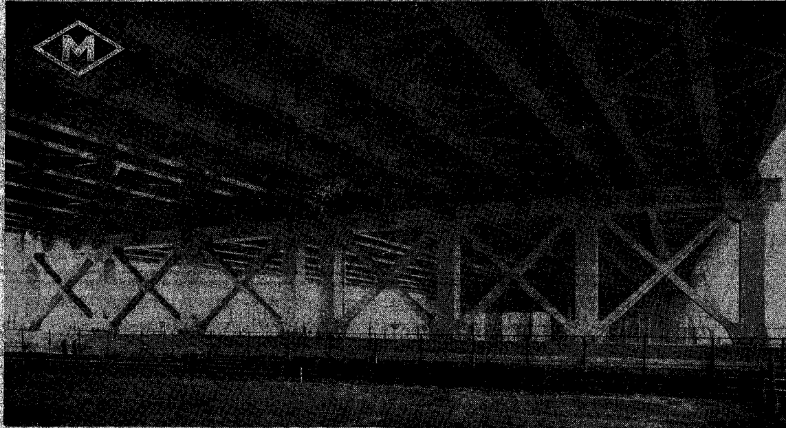
第三京浜川崎高架橋
