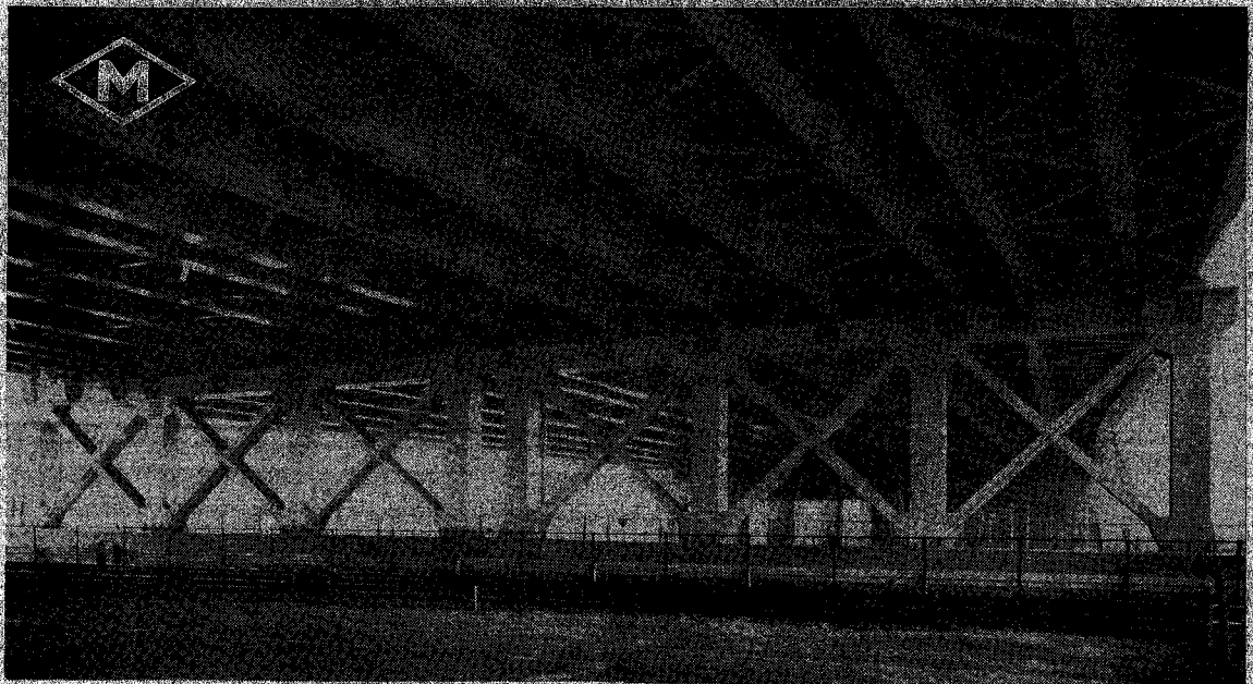
第三京浜川崎高架橋
