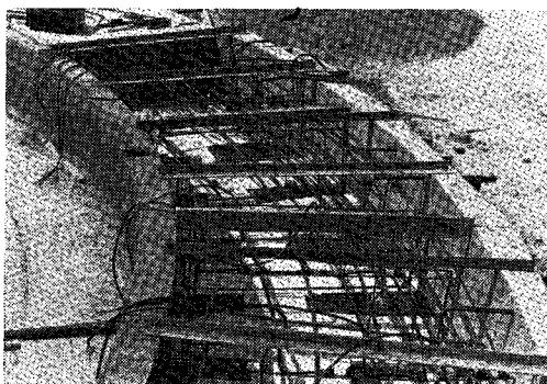
写真-6 ヒバラーによるPC鋼より線の緊張
