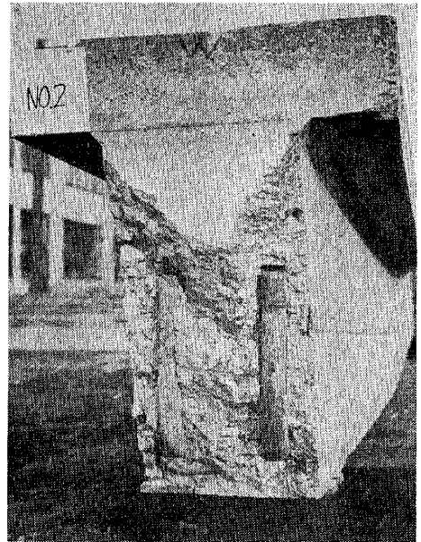
写真-6 静荷重試験における定着部破壊の状態
