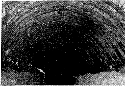
写真—4 鋼支保工にていったん全断面を保持し、コンクリートフォームにてつぎつぎにコンクリートを打ち込んで手前に行進する状況を示している
