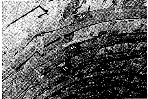
写真—9 コンクリート覆工に埋設するカーボンひずみ計のアーチ クラウン部のコンクリート打込前の図
