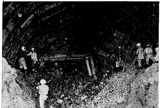
写真-2 アーチ鋼支保工を立込んだ後、隣接した正面切端の発破をかけた直後の状態を点検している所、手前にずりがおしだされ、支保工の上にも荷がかかっている
