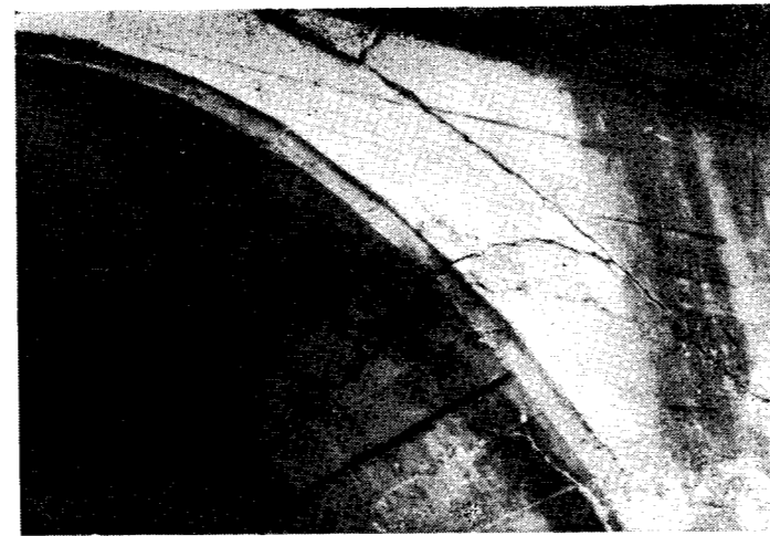
写真-10 拱渠の亀裂詳細
