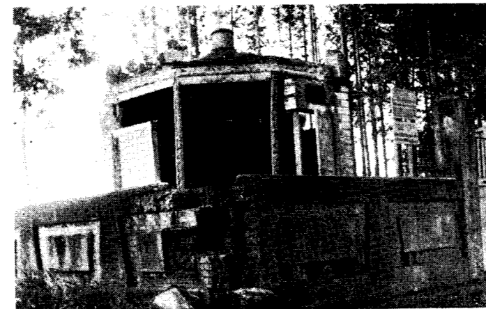
写真-11 宇都宮市上水道接合井の破壊
