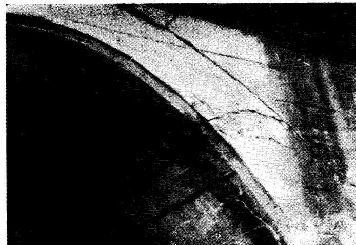
写真-10 拱渠の亀裂詳細
