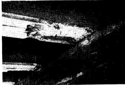
写真-4 県道橋大谷川橋主桁コンクリート剥離
