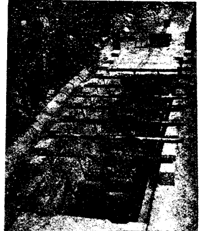
図-10 ピアノ線を予め引張る装置
