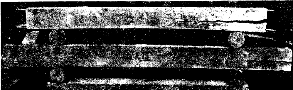
図-22 鋼弦コンクリート桁に生ずる水平ひびわれ
