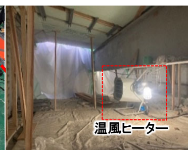
図-8 接合部下面養生
