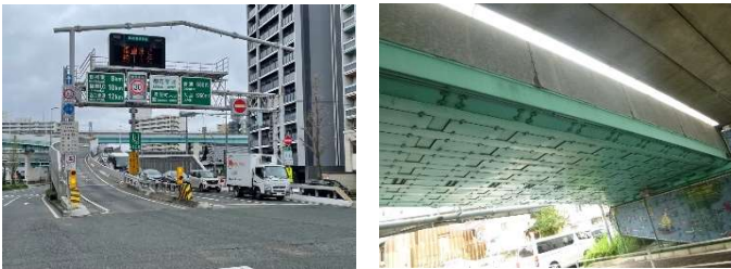
写真-1 呉服町出口と対象橋梁
