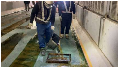
写真-4 防水材塗布
