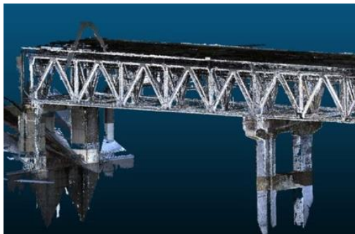
図-2 ドローン撮影から製作したモデル
