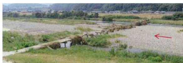
写真-2 潜水橋の流失事例 5)
