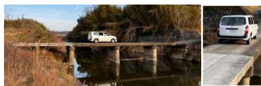
写真-1 頻度の多い潜水橋の例
