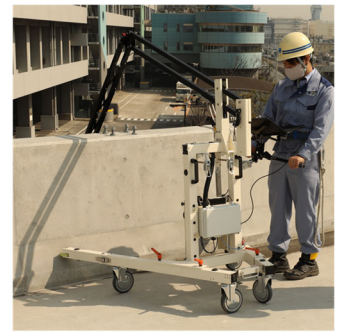
図4 ひび割れ検知ロボットによる撮影状況
