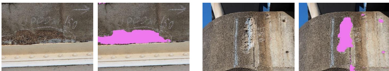
図2 コンクリートはく離の検出例（2例、各々左：入力画像、右：検出結果）
