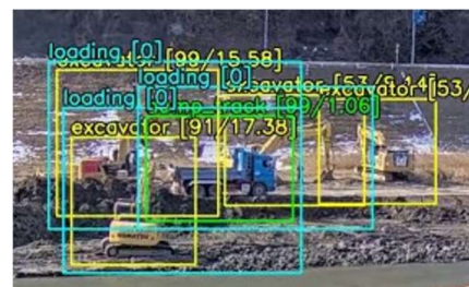
図 7 重機が密集した状況
