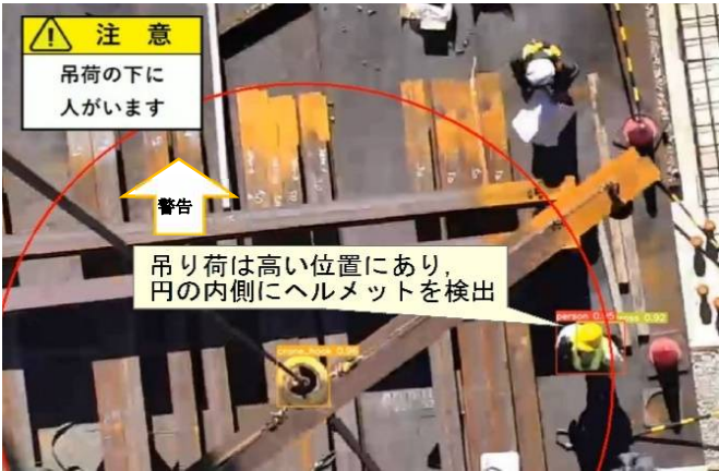
写真2 吊り荷下への作業員の立ち入りの検知
