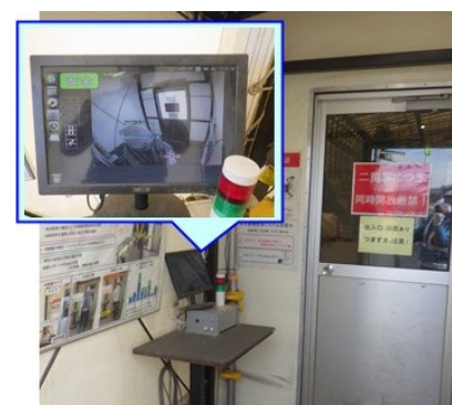
図7 モニター設置状況（歩きながら検知を確認）
