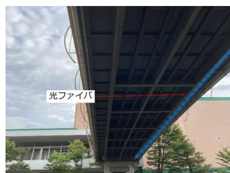
写真-2 光ファイバ敷設箇所
