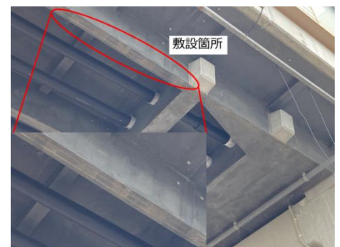
写真-3 主桁下面の様子
