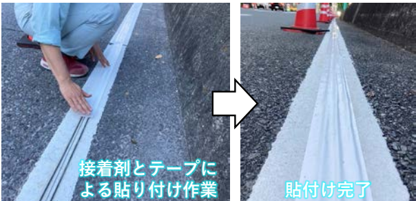
写真-1 貼り付け状況
