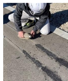
図-4.2 既設舗装への光ファイバ敷設状況
