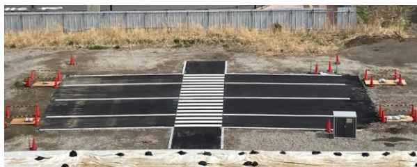
図-2. 試験舗装フィールド（鹿島技術研究所）
