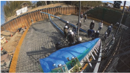
(a) 打込み区画全景の確認
