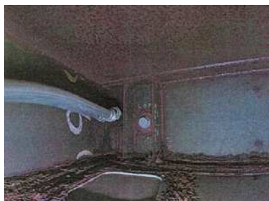
写真-4 ロボット撮影 2
