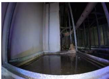
写真-8 ロボット撮影 3
