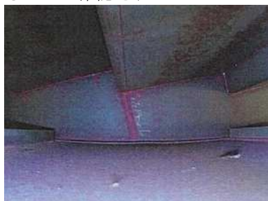
写真-3 ロボット撮影 1
