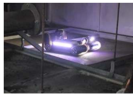
写真-10 ロボット点検状況
