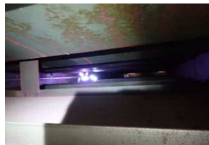
写真-5 ロボット点検状況
