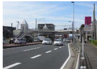
写真-7 こもれびの橋の外観
