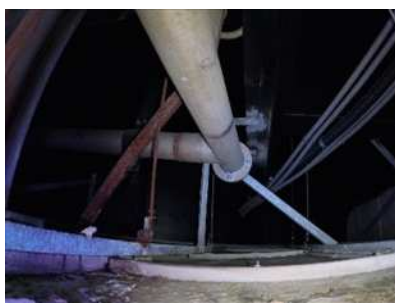
写真-9 ロボット撮影 4
