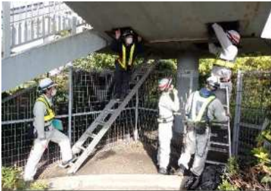
写真-1 ロボット搬入状況
