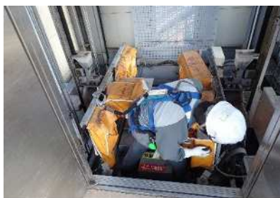
写真-6 ロボット搬入状況
