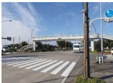
写真-2 瑞穂町富士山歩道橋の外観
