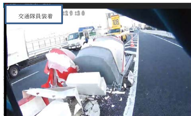
図-4 事象発生後の状況
