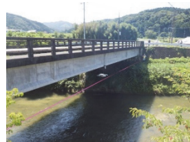
写真-3 ビニルテープ設置状況
