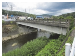
写真-1 新大島橋
