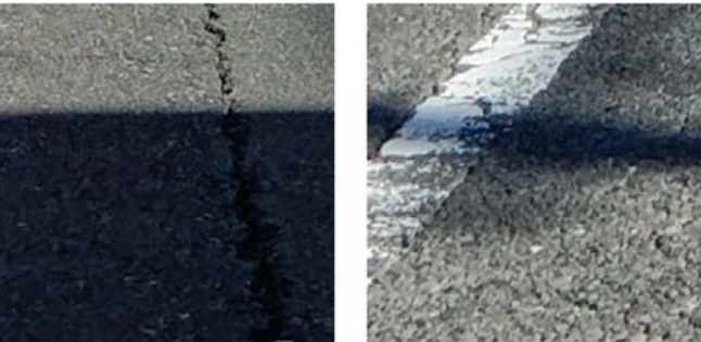
図-3 損傷の分割画像を健全と誤判定した例 (スマホ)
