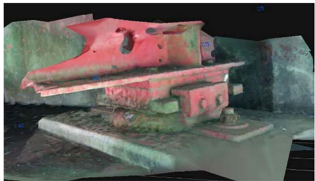
図-5 支承の計測
