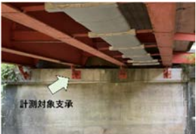
写真-1 計測箇所
