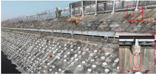
図-2 盛土の UAV-SfM 3D モデル（ケース⑥）
