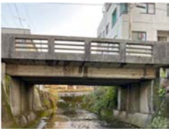
写真 2 RC 桁橋
