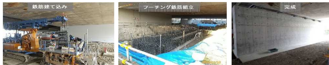
写真-1 低空頭での施工状況（増し橋脚）
