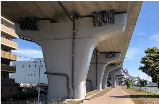
写真-5 水平力分担構造設置完了
