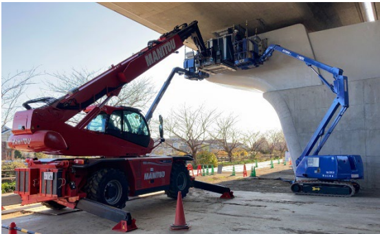
写真-4 テレハンドラー施工状況
