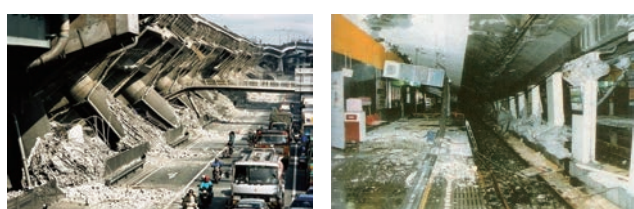
(a) ピルツの橋倒壊 (b) 地下鉄大開駅の被災状況
