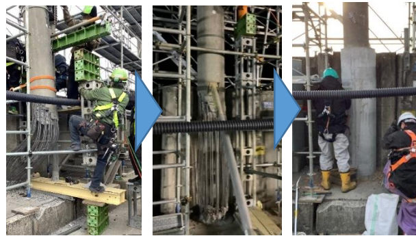
ジャッキアップ パイプサポートでの位置固定 断面補修による復旧 図-6 ジャッキアップによる復旧
