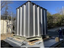
写真-1 SUS 貯水槽
