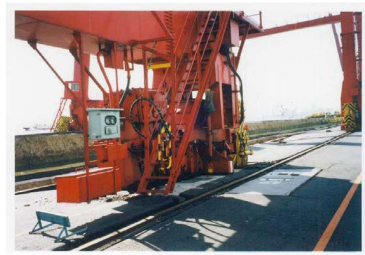
図-5 陸側レール基礎が地盤改良の場合の被災事例 (六甲アイランド RC-4)。陸側レール周辺が平らになっている。
