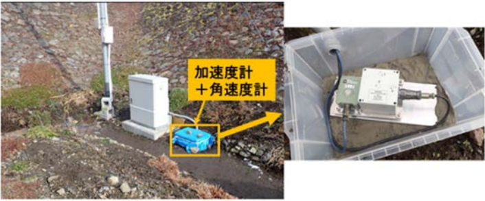
図4 地震観測における機材設置状況
