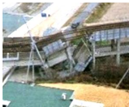
(a)伊川橋東橋台 (神戸市) (b)松林寺架道橋 (西宮市) 図8 山陽新幹線高架橋の局所的被害例
