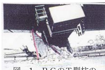
図-1 RCのT型柱の せん断破壊例
