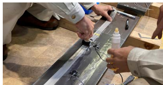
写真-3 接着状況
