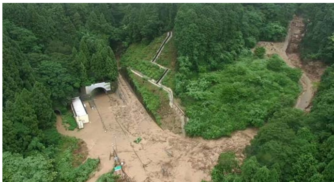
写真-1 北陸自動車道（下り線）敦賀トンネル南坑口付近被災状況
