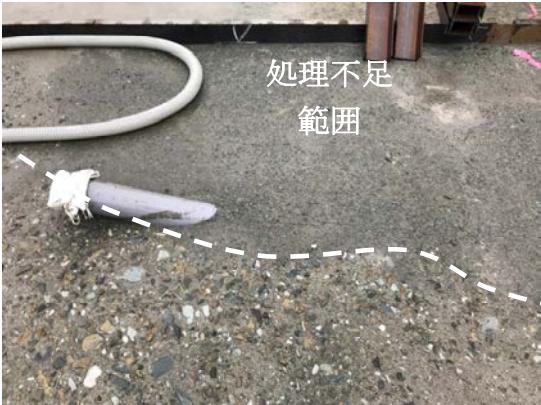
写真－1 打継面の処理状況
