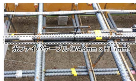
図-3 光ファイバケーブル (試験体内部)
