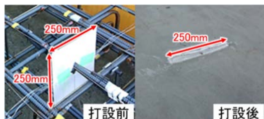
図-4 模擬ひび割れ
