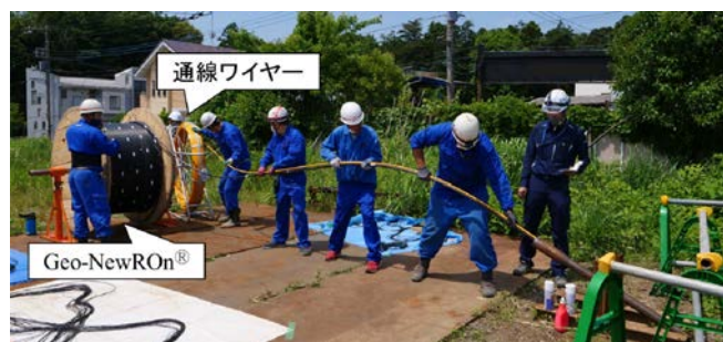
図一5 Geo-NewROn ® 敷設状況
