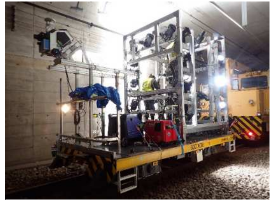
図-1 高解像度デジタルカメラとレーザスキャナを使用したトンネル検査事例
